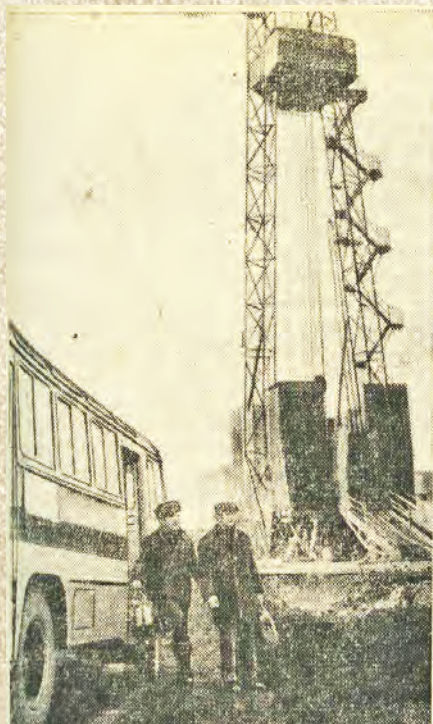
Доставка буровиков на объект
