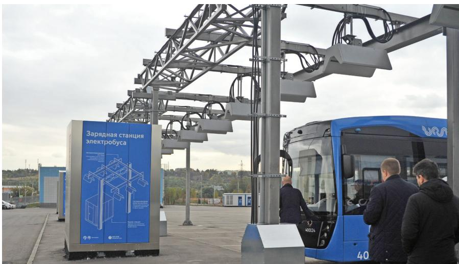
На территории автопарка расположено 204 зарядных поста, их энергообеспечение осуществляют 34 современные зарядные станции с системой динамического распределения мощности
