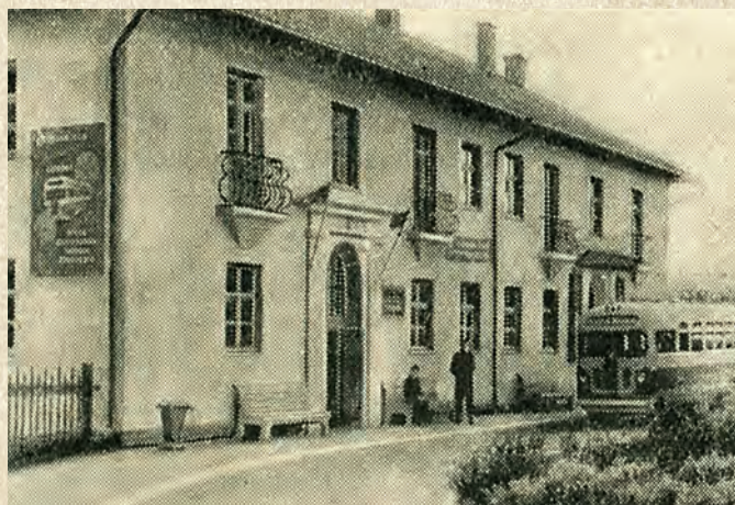
Гостиница при Симферопольской станции обслуживания автомобилей Крымского автотреста
