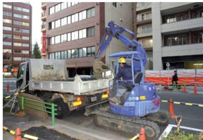
Ремонтные работы в Токио ведутся быстро, аккуратно и качественно
